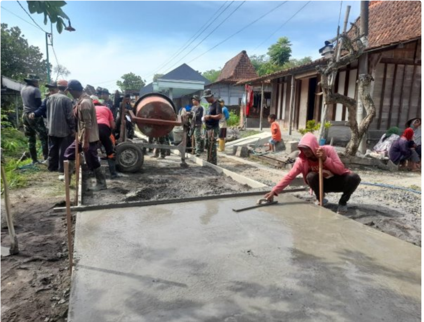
Proses Pengecoran Jalan Program TMMD Reg Ke-117 Di Desa Cangkring
